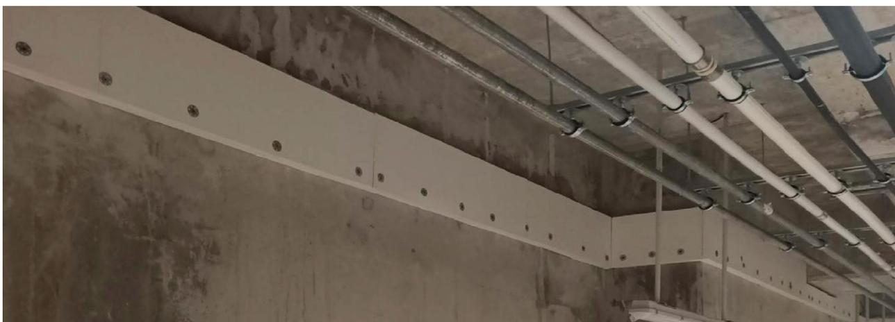
Les appuis en néoprène sont des éléments importants dans les bâtiments car ils transmettent les charges normales à son plan et permettent en même temps d'absorber par rotation et distorsion les déformations et translations de la structure lorsqu'elles sont limitées.
